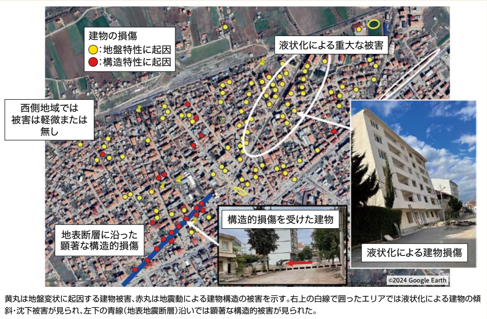
図2 ギョルバシュの被害状況
