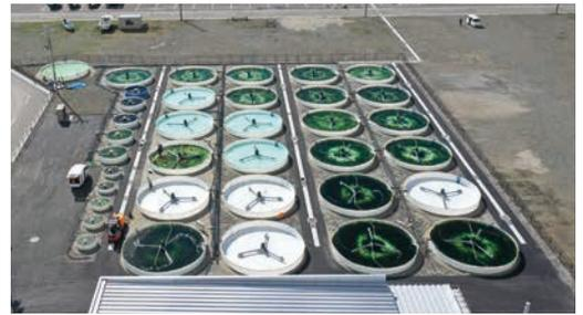
2021年に理研食品は、近年国内主要産地での生産量が激減したスジアオノリやヒトエグサの陸上養殖施設を岩手県の陸前高田市に開設した。スジアオノリの製造販売はすでに始まっており、ヒトエグサも大いに期待されている。また、22年度の実績では屋外の季節変動に応じてタンクの肥料濃度・海水供給量・エアレーションをコントロールしながらスジアオノリを乾重量3.1トン生産できた。これはCO<sub>2</sub>固定換算をすると1トンの炭素または3トンのCO<sub>2</sub>を固定したことになる。
