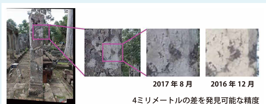
図5 撮影時期の異なる写真から抽出した損傷の様子。2016年と17年の状態を比較し、4ミリメートルの変化を発見できる。
