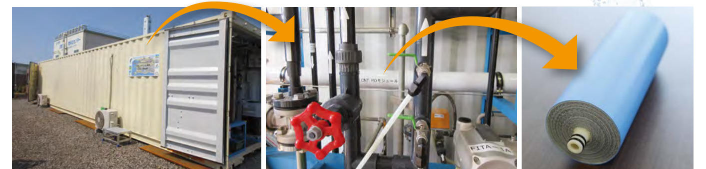
■図6 海水淡水化のパイロットプラント。長さ約12メートルのコンテナ内に、ナノカーボン複合RO膜モジュールを搭載した海水淡水化装置、膜の耐久性などを評価するための薬品ユニット、水槽などを設置している。最初に汚れを取り除いた後、海水に高い圧力をかけ、膜モジュールに通して塩分を取り除く。
