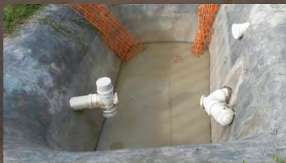
■図4 鉛不動態化剤の効果を現地で検証している。盛り土の中心に集水ピットを設け、浸出水の成分を分析する。水に含まれる鉛の濃度で鉛不動態化効果を確認する。
