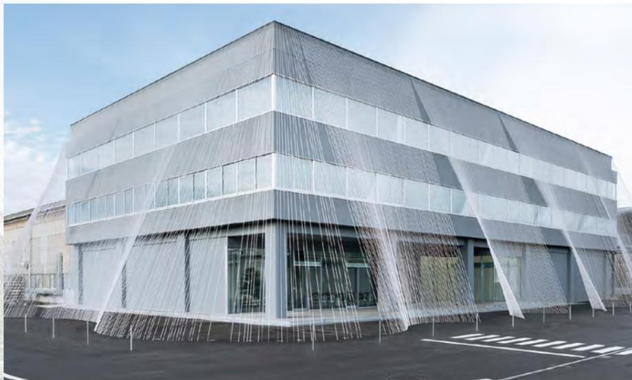
■図6 小松精練日本社棟の改築工事に初めて「カボコーマ・ストランドロッド」が用いられた。建物に繊細なレースをかけるような印象的な外観で、同時に耐震補強を実現する。
