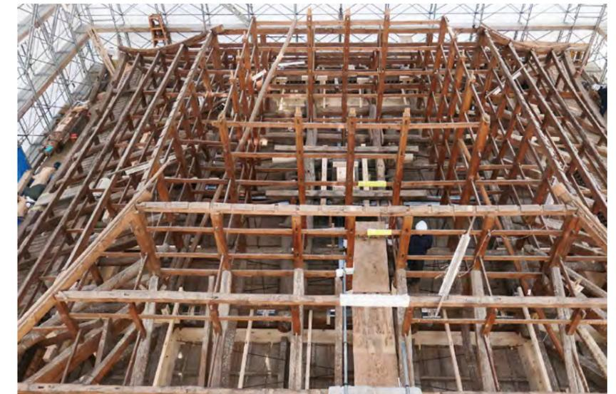
■図7 2017年1月に行われた善光寺「経蔵」の耐震補強の施工状況
