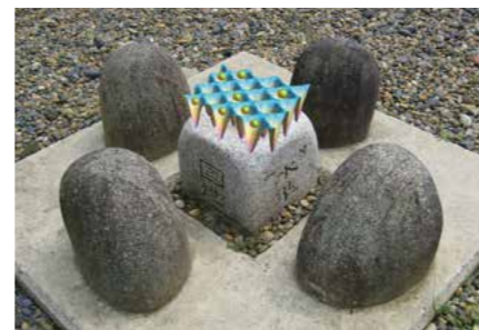
水準測量で標高の基準となる水準点に、光格子の模式図を載せた。将来は光格子時計が「量子水準点」になるかもしれない(国土地理院提供写真を加工して作成)。
