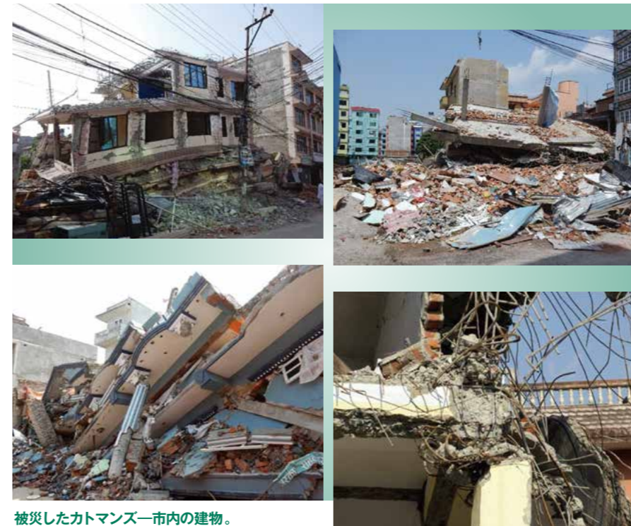
被災したカトマンズ市内の建物。
