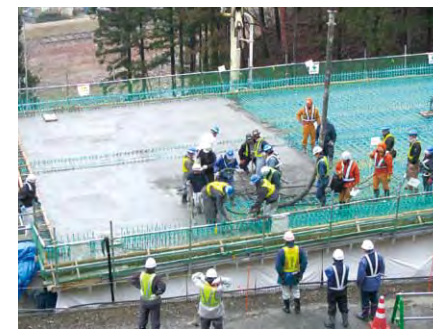
多重防護を施した高耐久鉄筋コンクリート製の床版の施工。防錆鉄筋（青色）やフライアッシュ（石炭燃料のときに出る微粉末の灰）を用いたコンクリートにより高耐久化を図る。
