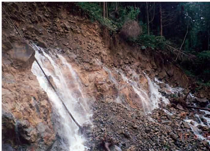
写真は鹿児島県始良郡湧水町で1993年8月に起きた表層崩壊の現場。 提供：鹿児島大学 地頭隆教授
