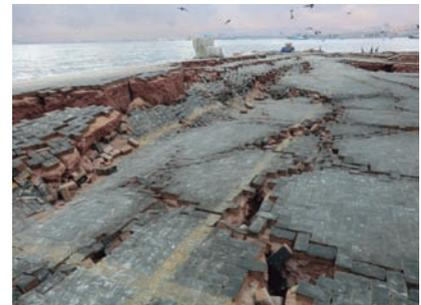
地震動により被害を受けたイキケ港の埠頭。余震によっても被害が拡大。
