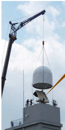
大阪大学・吹田キャンパスに2012年に設置されたフェーズドアレイ気象レーダー（左、設置工事の様子）とそのアンテナ部分（上）。半径20～60km、高度14kmの詳細な降水分布が観測できる。従来5分以上かかっていた観測をわずか10～30秒に短縮した。 （写真：情報通信研究機構）
