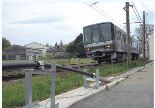
7月の走行試験の様子。手前が超伝導ケーブル。
