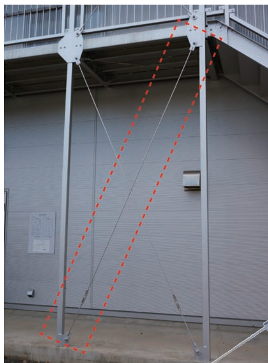
貝沼さんらは現在銅系形状記憶合金の超弾性効果を活用した建築部材の開発を進めている(写真上・右はそのイメージ)。数%伸び縮みしても元に戻り、制震性に優れている。
