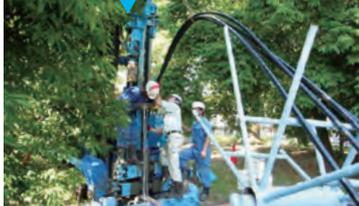
埼玉大学の構内の一角で約50mの深さまでボーリング掘削を行い、ヒートポンプシステムを設置。5mごとに温度センサーも設け、システムの使用による地下水の温度変化などの影響を調査する。
