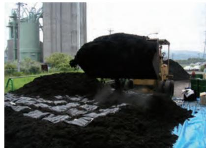
海に流れ出たドロドロの重油をオイルフェンスで囲い、油吸着材に吸わせて回収(写真上)。それをバーク堆肥の上にくくと、堆肥に含まれる微生物によって、2カ月もすると重油が分解される(写真下)。
