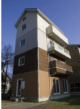
木造建築の使用を推進するために、耐火構造の大型建造物を作る研究も実施されている(写真は建築研究所の構内に建てられた4階建木造試験体)。最近では老人ホームのような大型施設も、木造で建てられるようになってきた。
