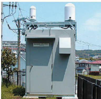
原子力利用施設周辺に設置されたモニタリングポスト 今回の開発で安全監視の精度が高まります。
