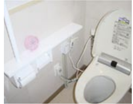
バイオトイレは、し尿や厨芥を雑排水から分離し、再利用できるよう設計されている。現在、北海道旭川市、埼玉県秩父市、沖縄県宮古島、中国(南京、西安、長春)などで実証実験がおこなわれている。
