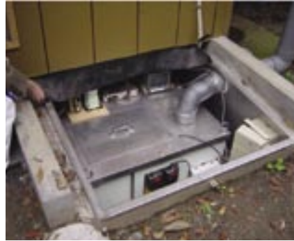
バイオトイレは、し尿や厨芥を雑排水から分離し、再利用できるよう設計されている。現在、北海道旭川市、埼玉県秩父市、沖縄県宮古島、中国(南京、西安、長春)などで実証実験がおこなわれている。
