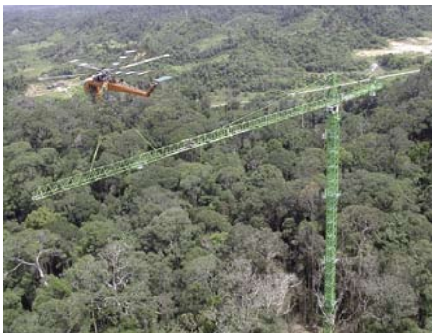
マレーシア連邦サラワク州の熱帯雨林に建設された林冠クレーン。森林を破壊しないよう、部品の組み立てにはヘリコプターが使われた。
