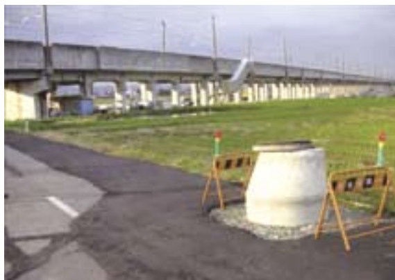
新潟県中越地震では、マンホールが浮き上がる(手前)ほどの地盤液状化が起こったにもかかわらず、補強がすすんでいた新幹線の橋脚は無傷だった。
