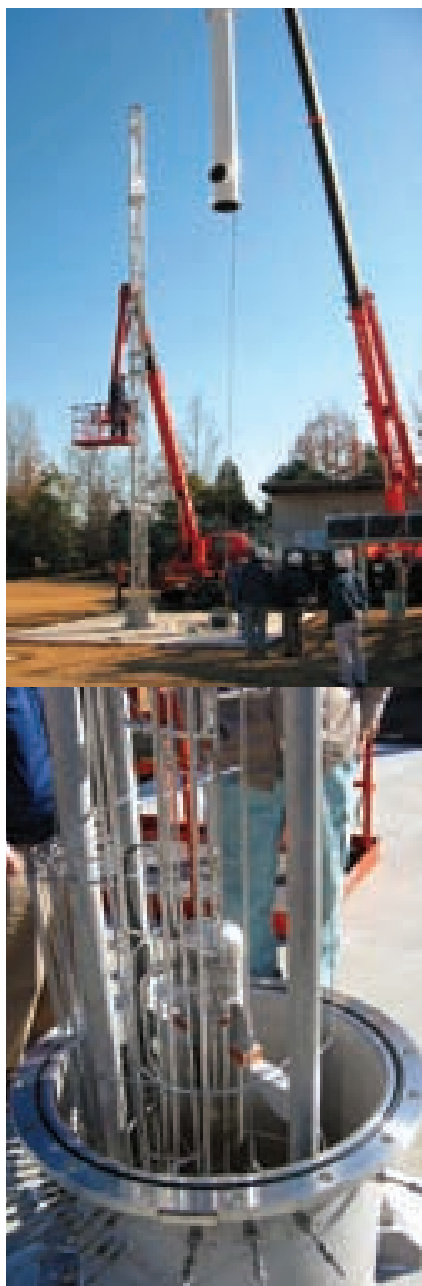
左) 実験装置の建設風景と装置の内部 上) 製造装置は高さ70m。蒸留塔が何系統かに分けて納められている。年間100kgの製品を製造できる。
