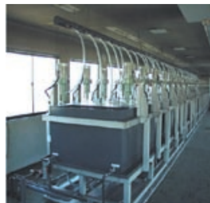
図3 実証プラント抽出装置（右面）
