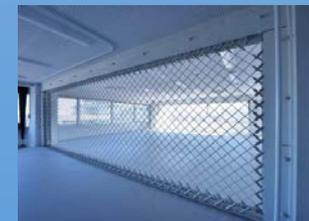
CFRPストランドロッドによる耐震補強実装試験（小松精練 fa-bo）
