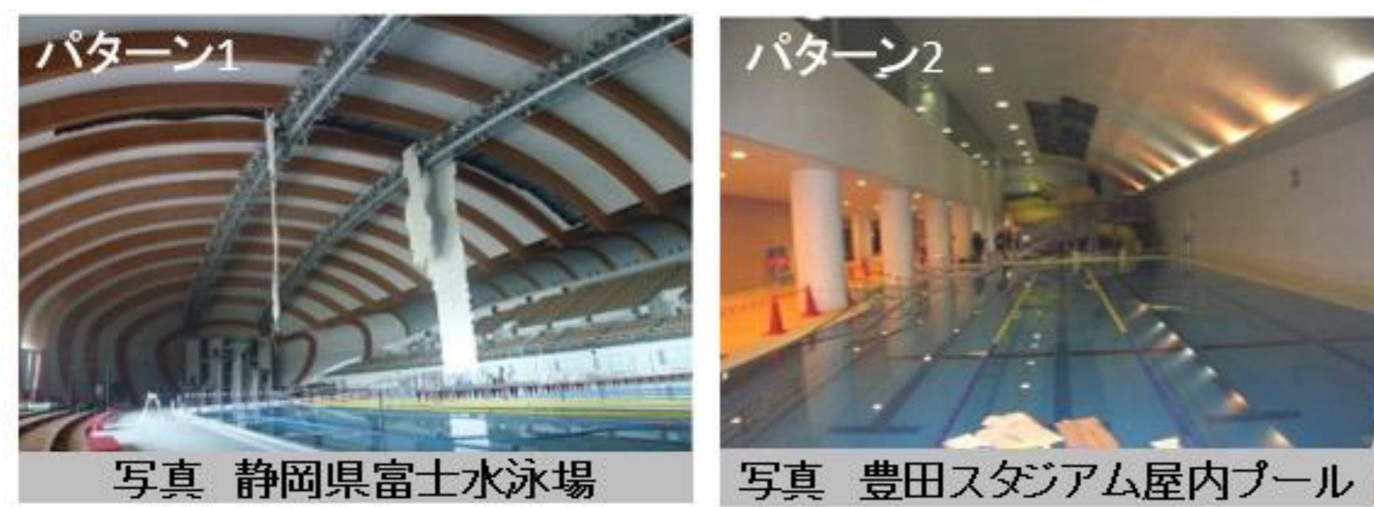
経年劣化が原因で落下した被害例
