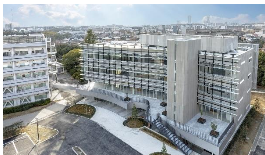
写真. 大阪大学 MA-T 共創センター（杏の杜）.
