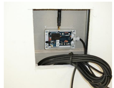
図 7-3 非構造部材の計測
