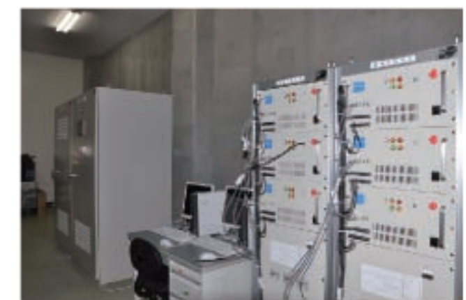
パワーネットワークシステム
