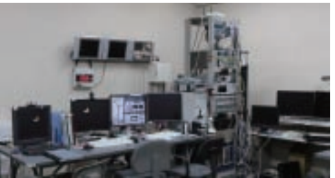
モニタリング室(高周波試験装置を含む)
