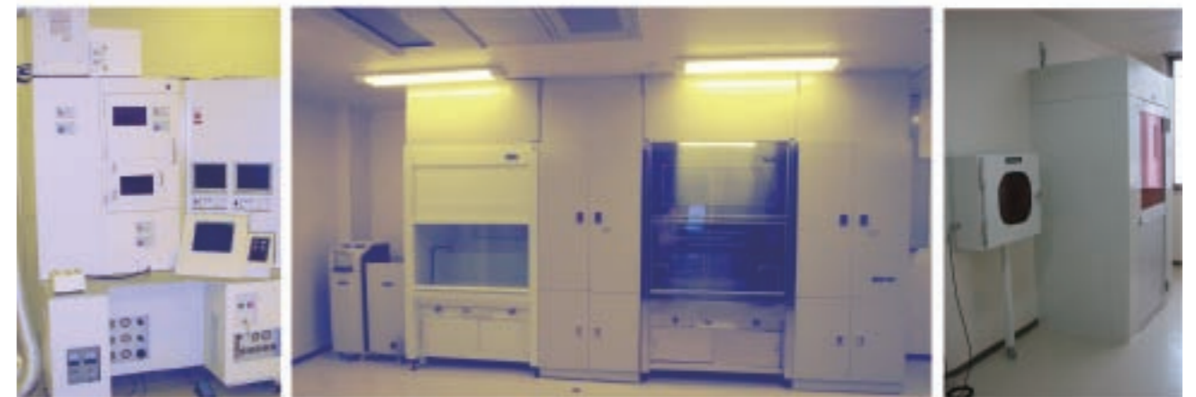
投影露光装置（オレンジ照明クリーンルーム内） 超純水製造装置およびクリーンドラフト（オレンジ照明クリーンルーム内） クリーンルーム入口（エアシャワーとパスボックス）
