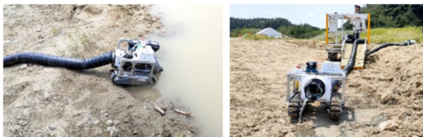
図 73: 排水用ホース敷設機「i-Centipot hose Ammonite」によるホース敷設、揚水、排水
