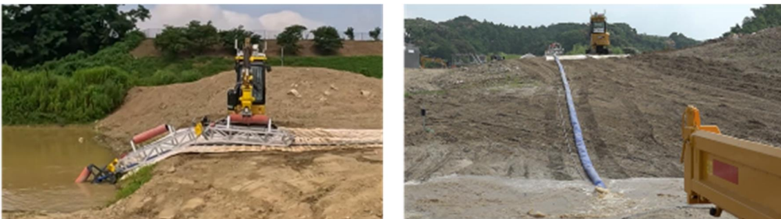
図 50: 連結型排水ポンプ設置フレームによる排水ポンプの設置および排水
