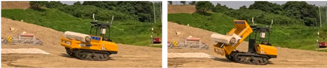
図 48: 自動走行クローラダンプによる資機材運搬および設置
