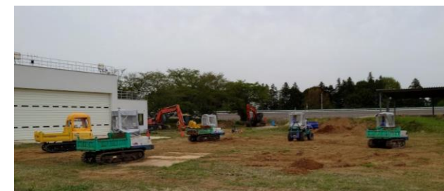
図6 複数建設ロボットによる土砂運搬作業の動作
