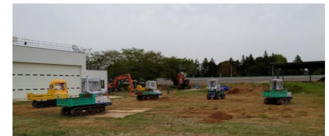
図6 複数建設ロボットによる土砂運搬作業の動作
