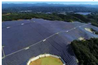
メガソーラの例 260 MW（岡山）
