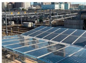
高輪ゲートウェイ駅(太陽光パネル)
