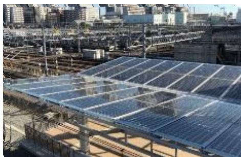
高輪ゲートウェイ駅 (太陽光パネル)
