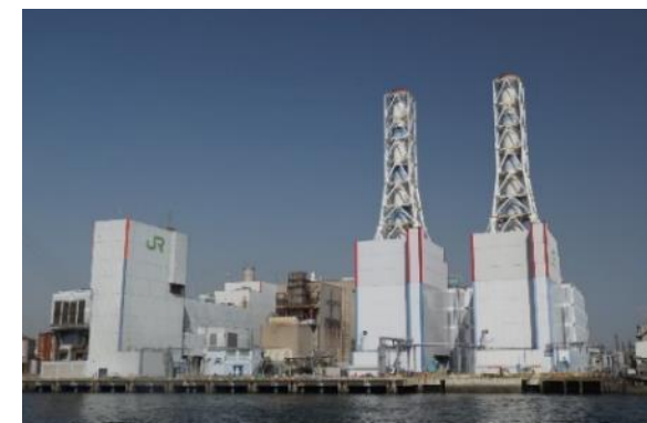
川崎発電所全景
