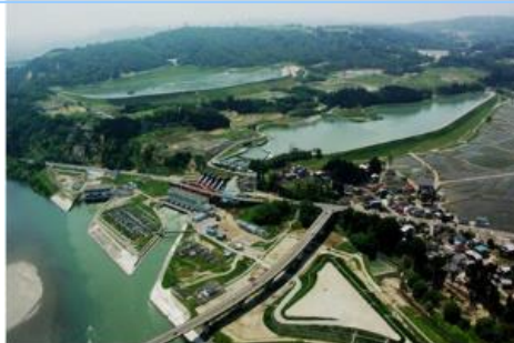
小千谷・小千谷第二発電所全景
