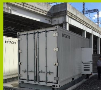
電力貯蔵装置
