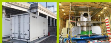
電力貯蔵装置
