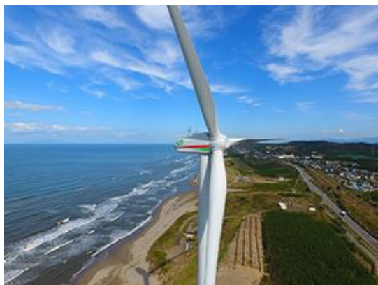
JR秋田下浜風力発電所 (2016稼働)
