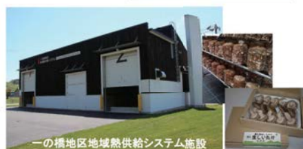
一の橋地区地域熱供給システム施設
