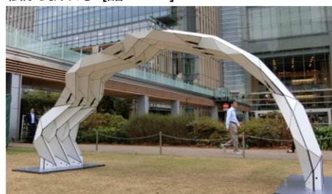
図 2 : 板材の折り曲げを使うと、構造性能を発揮し仮設建築へつながる [館 安藤 重松 森島 2018]
