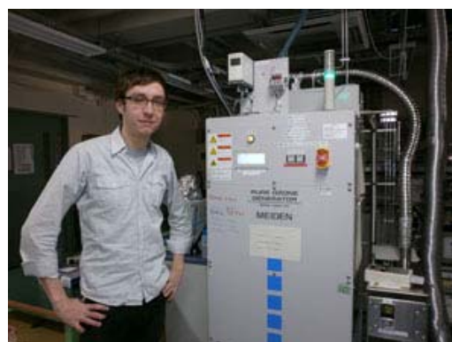
高純度オゾン供給装置
