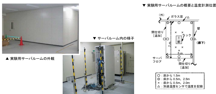
図 3：ミニ DC の様子と温度センサの配置
