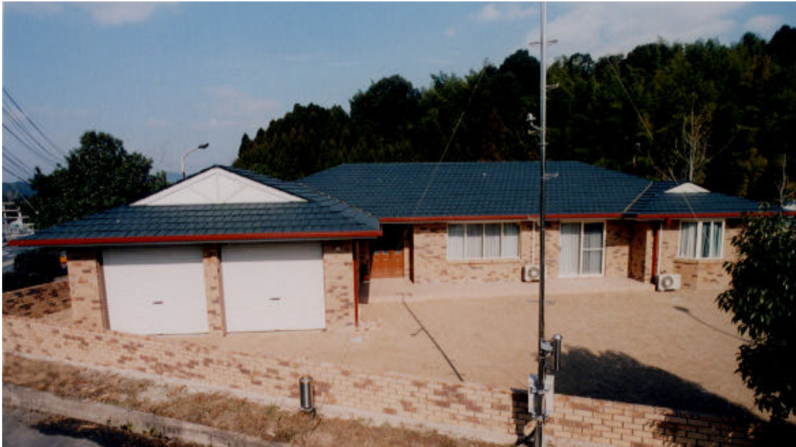
図 1 熊本県玉名郡菊水町に建設した煉瓦造住宅実験棟
