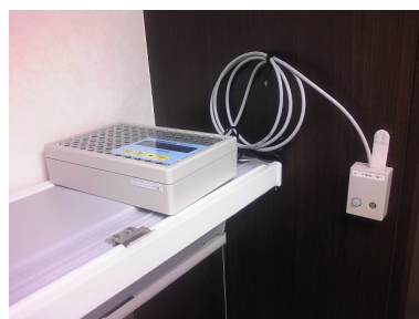
図5.4 計測器の設置状況
