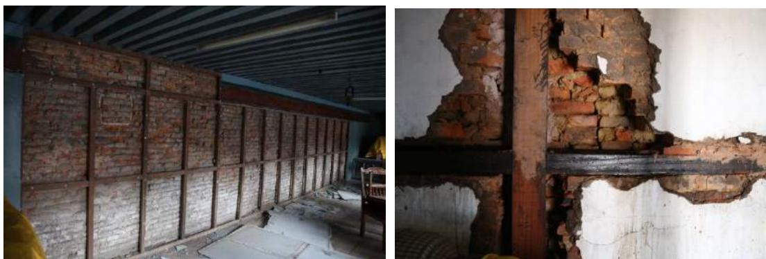
図-15 補強方法の一例(水平・鉛直材の挿入やその水平材との接合)
