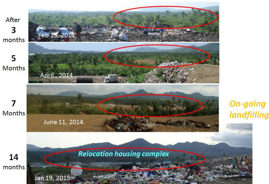
図-1 発災後の St Nino 処分場と周辺環境の変化
