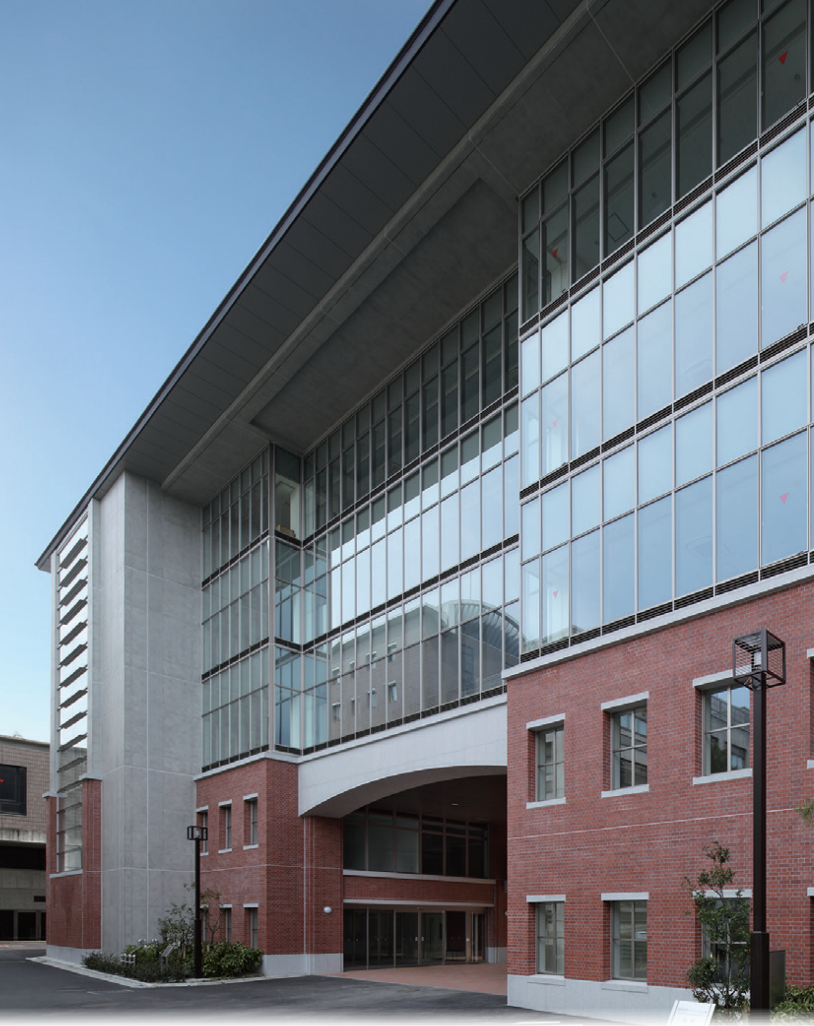
京都大学国際科学イノベーション棟 International Science Innovation Building, Kyoto University
