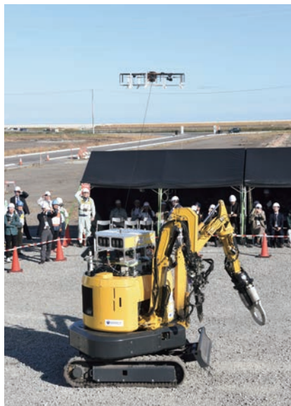
【写真8】建設ロボと有線ドローン
