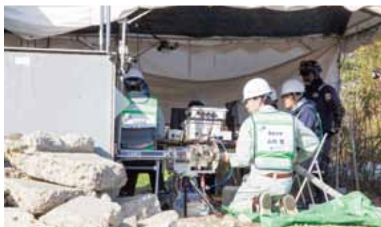
【図5】自動挿入機により被災建物内へ送られる能動スコープカメラ
