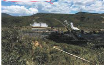
本プロジェクトの対象フィールド であるオルカリアII地熱発電所
