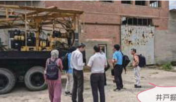
井戸掘削技術の調査
