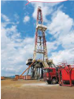
本プロジェクトの対象 フィールドであるメネンガイ 地域の地熱井掘削リグ
