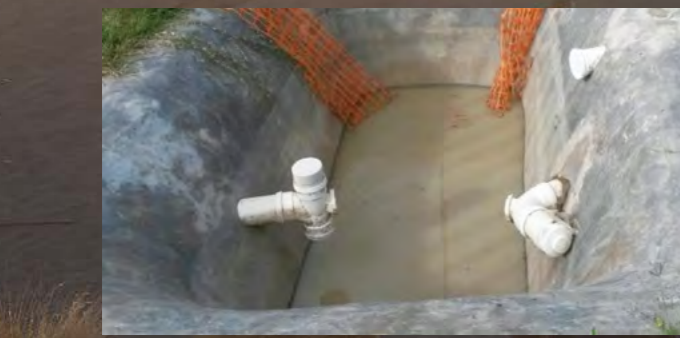
図4 鉛不動態化剤の効果を現地で検証している。盛り土の中心に集水ピットを設け、浸出水の成分を分析する。水に含まれる鉛の濃度で鉛不動態化効果を確認する。
