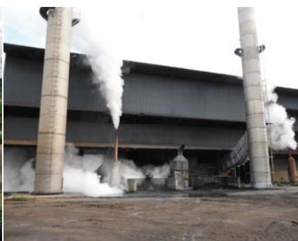
ボイラーから放出される高圧蒸気
