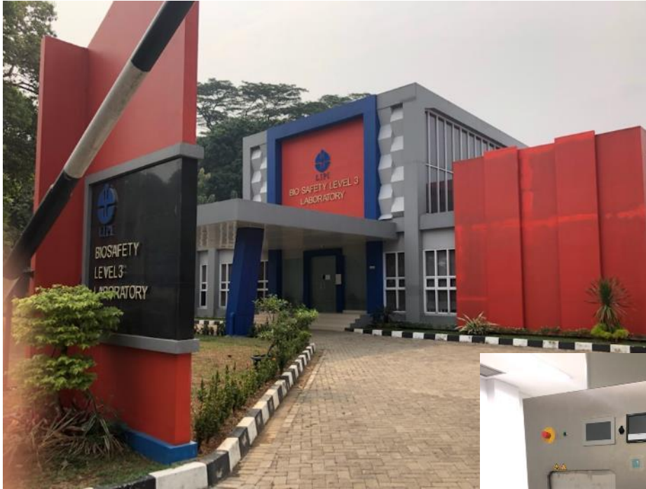
Biosafety Level 3 施設建設
