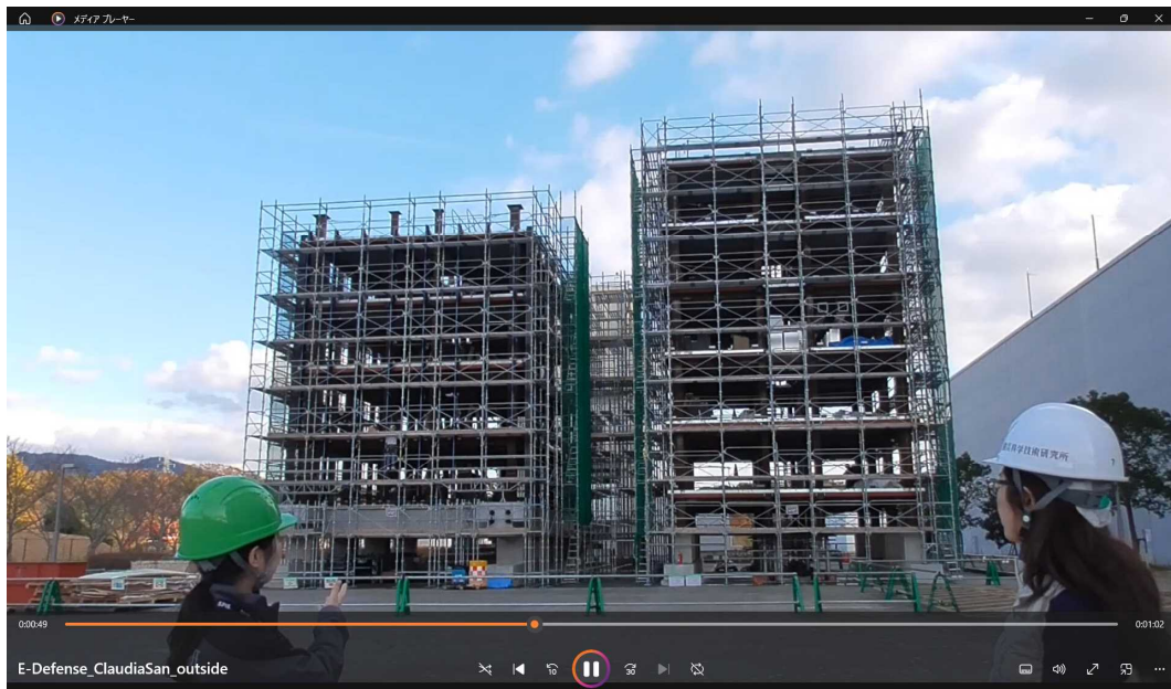
図 26 大型実験の 11 月建設現場取材
